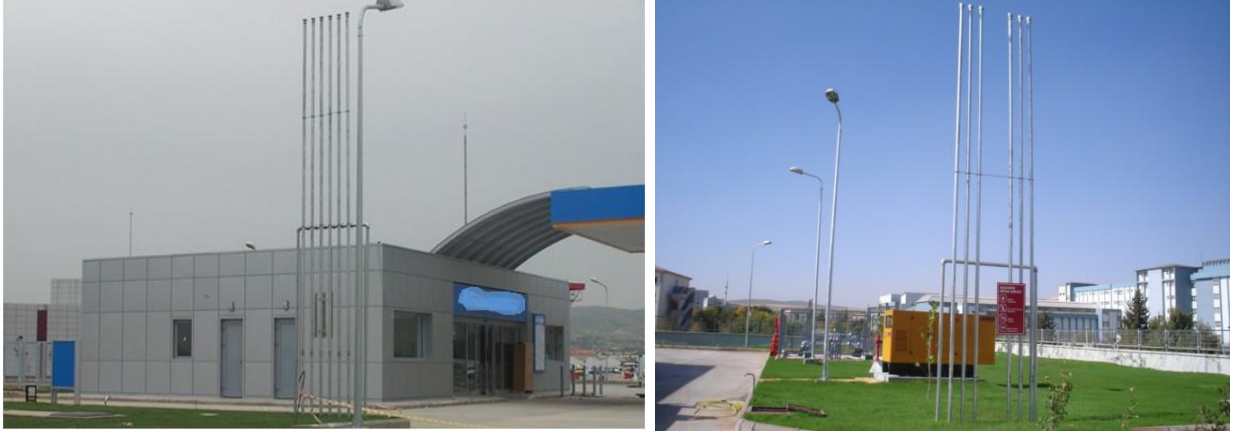
Şekil 10. İstasyonda yer alan havalandırma boruları (nefeslik)
