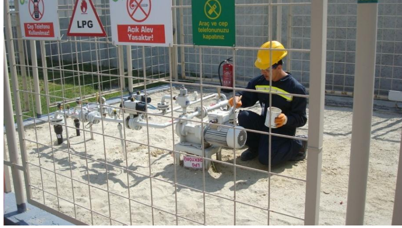
Şekil 16. LPG depolanması ve uyarı işaretleri
