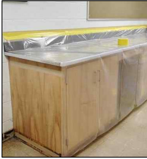
Şekil 24. Taşınmaz malların kaplanması
