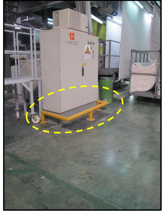
Resim 4.4. Forklift çarpması sonucu eğilen direk ve çarpmayı önleyen koruma
