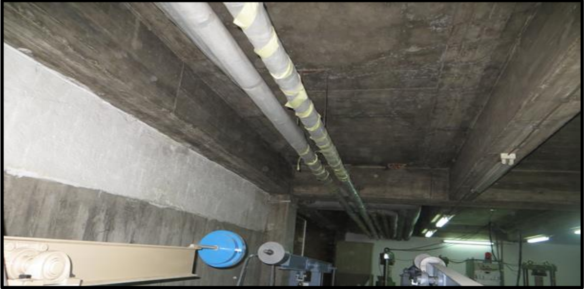
Resim 3.3. Söküm Sahası 2 - Asbestli izolasyon malzemesi sökümü (laboratuvar)
