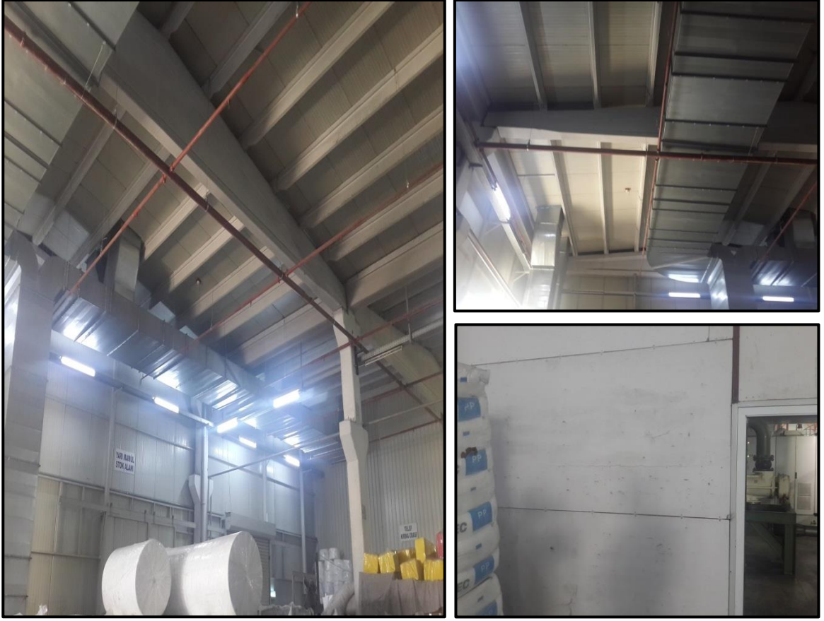
Resim 4.31. Depo alanlarında alev dedektörleri, sprinkler tipi yangın söndürme sistemleri ve yanmaz malzemedan duvar kaplama uygulamaları
