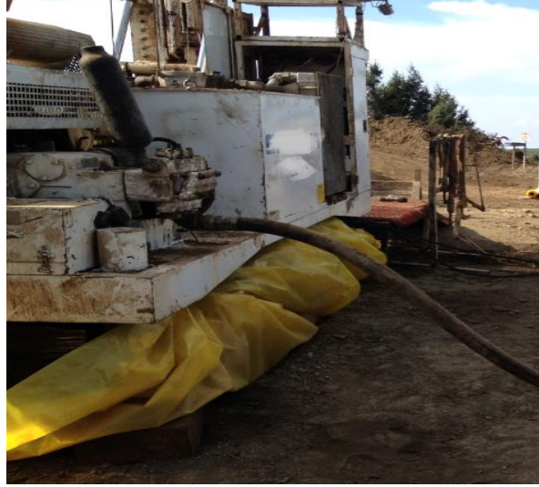
Resim 4.26. Gözlem yapılan sahaların birinde yer alan sondaj makinesi taban desteđi
