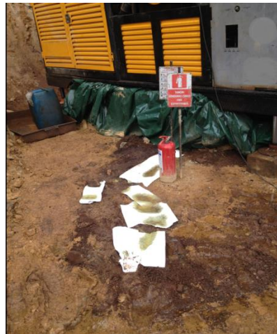
Resim 4.15. Gözlem yapılan sahaların birinde sondaj makinesinden damlayan yağın topraktan emilmesini sağlamak amacıyla konulmuş emici pedler
