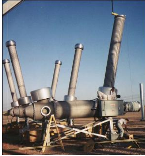
Şekil 13: Yüksek gerilim kesicisi
