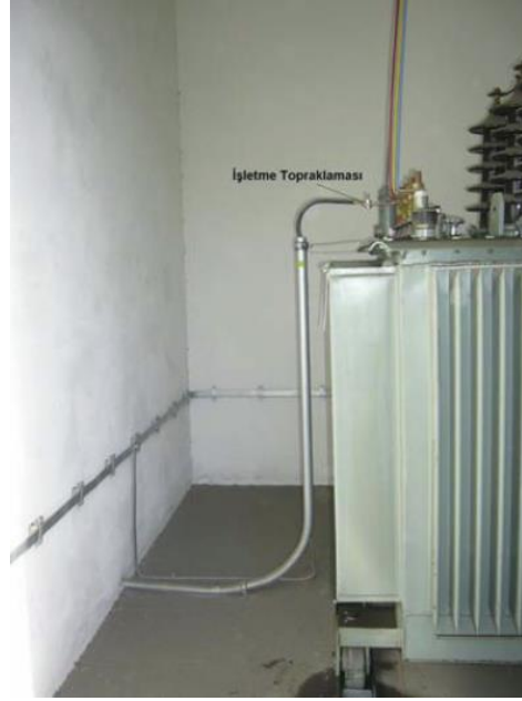
Şekil 11: İşletme Topraklaması Bağlantısı
