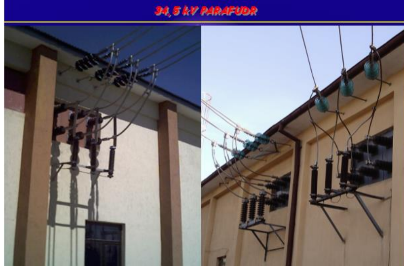
Şekil 20: 34,5 kV Parafudr Bağlantısına Örnek
