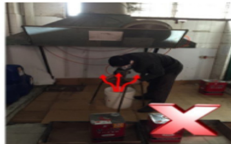
Resim 4. Tavsiye Edilen ve Edilmeyen Lokal Havalandırma Sistemi Düzeni Örnekle
