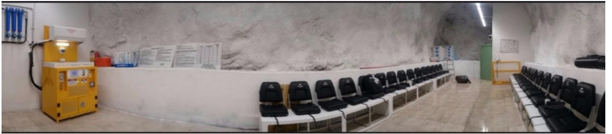
Şekil 4.26. Sabit sığınma odasının içeriden görünüşü
