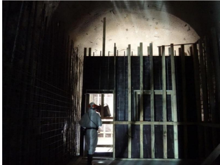
Şekil 4.18. İşletmede yapım aşamasındaki sabit sığınma odası
