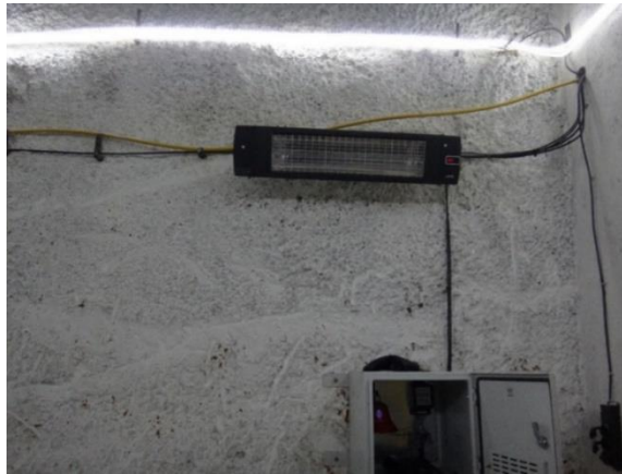
Şekil 4.24. Sabit sığınma odasında bulunan ısıtıcı
