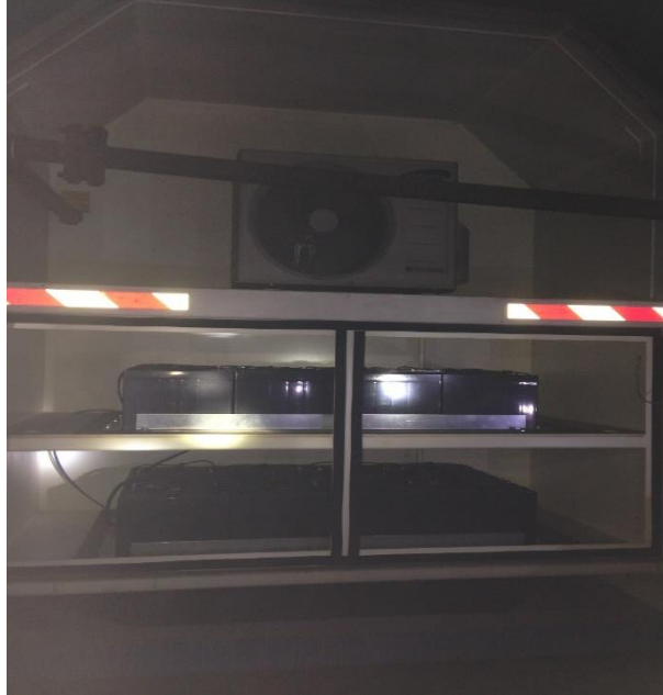
Şekil 4.6. Taşınabilir sığınma odasına ait bataryalar
