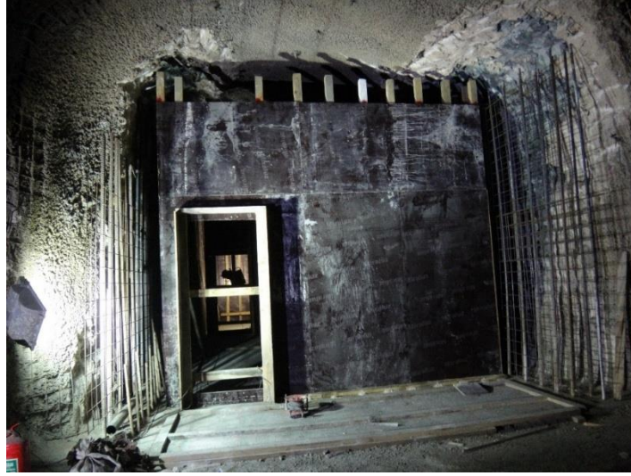
Şekil 4.17. İşletmede yapım aşamasındaki sabit sığınma odası
