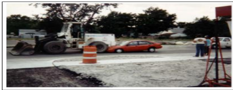
Resim 2.1. Yeterli Ara Açıklık Bulunmadığında Oluşan Kaza Örneği [12]
