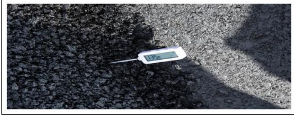
Resim 4.10. Yüksek Sıcaklıktaki Çalışma Alanı
