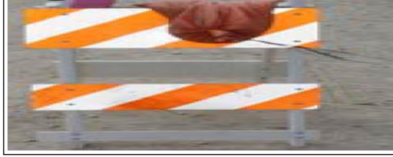
Resim 2.3. Ekipmanın Uygunsuz Şekilde Sabitlenmesi [12]
