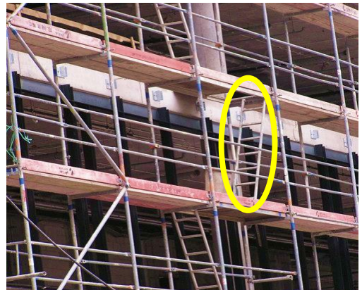
Şekil 8: İskele içi merdivenler
