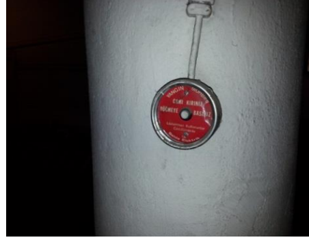
Resim 4.9. Bakım ve kontrolleri yapılmayan dedektör ve yangın alarm butonu
