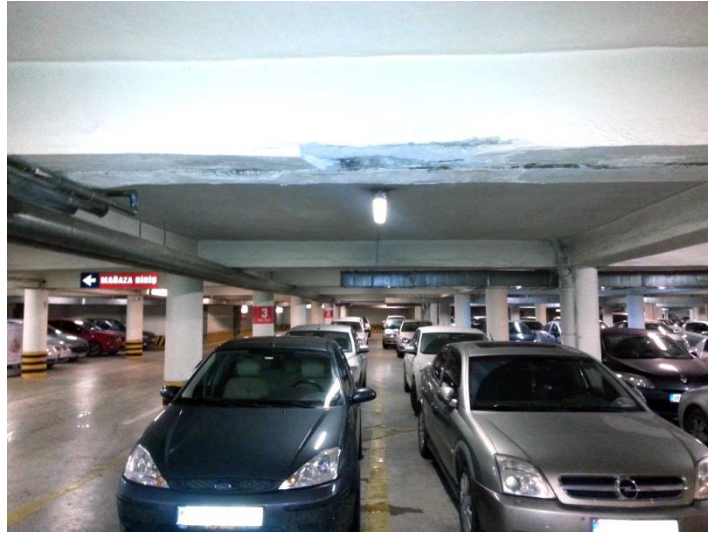
Resim 4.6. Yağmurlama sistemi bulunmayan otopark örneği
