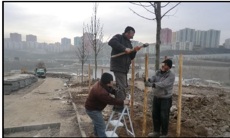
Resim 4.32. Hereklerin çakılması
