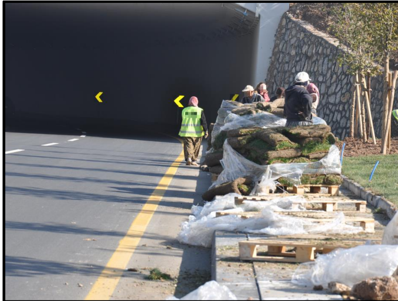
Resim 4.10. Refüjde rulo çim serimi hazırlıkları
