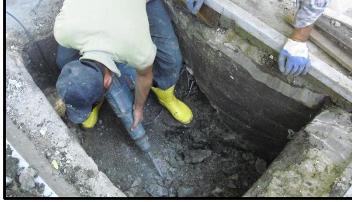
Resim 4.41. Sıhhi tesisat bakım onarımı
