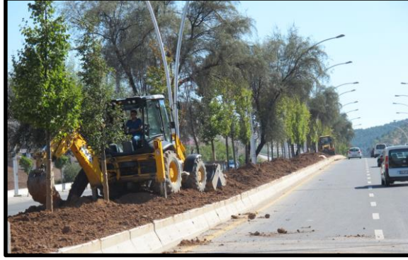
Resim 4.34. Refüjde toprak tesviyesi
