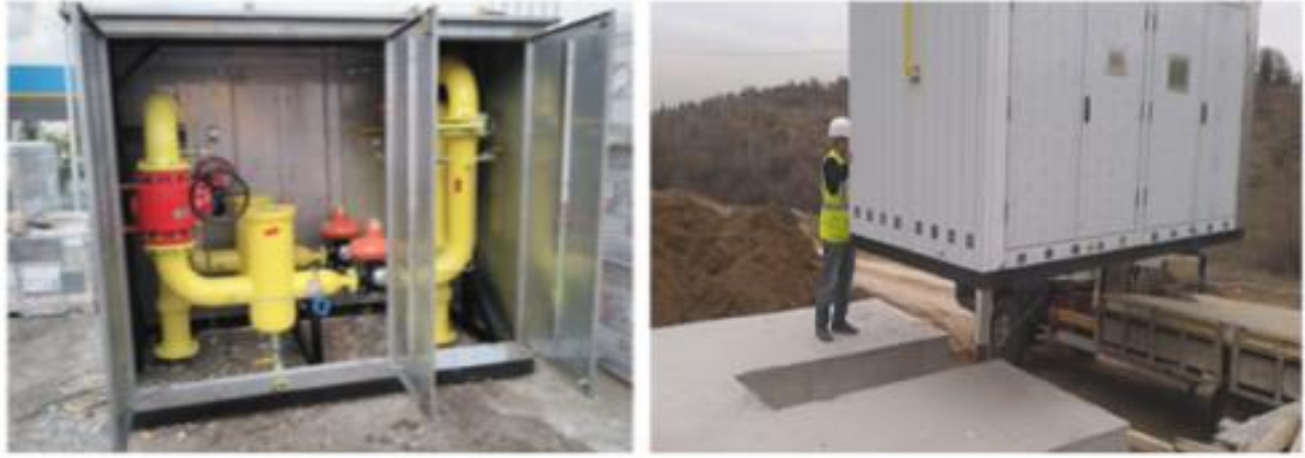
Resim 4.4. RMS-C tipi istasyon montajı
