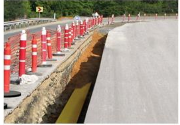
Resim 4.3. Çelik ve polietilen doğal gaz boru montajı işlemleri
