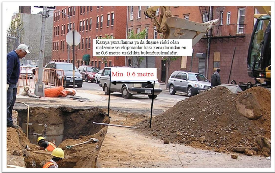
Şekil 6. Hafriyat yığını dar kesitli kazıdan yeterli uzaklıkta tutulmalıdır [10]
