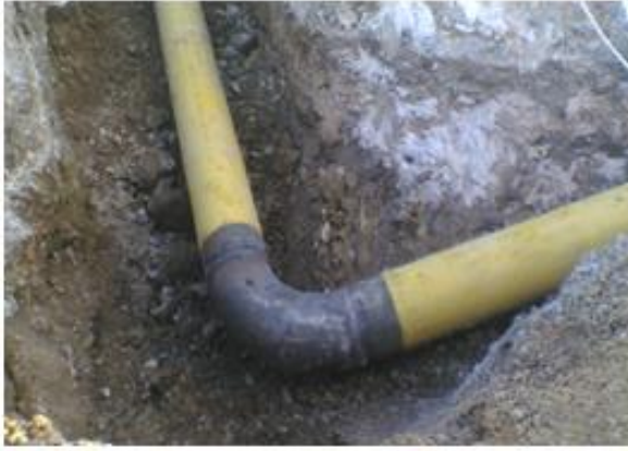
Resim 4.3. Çelik ve polietilen doğal gaz boru montajı işlemleri
