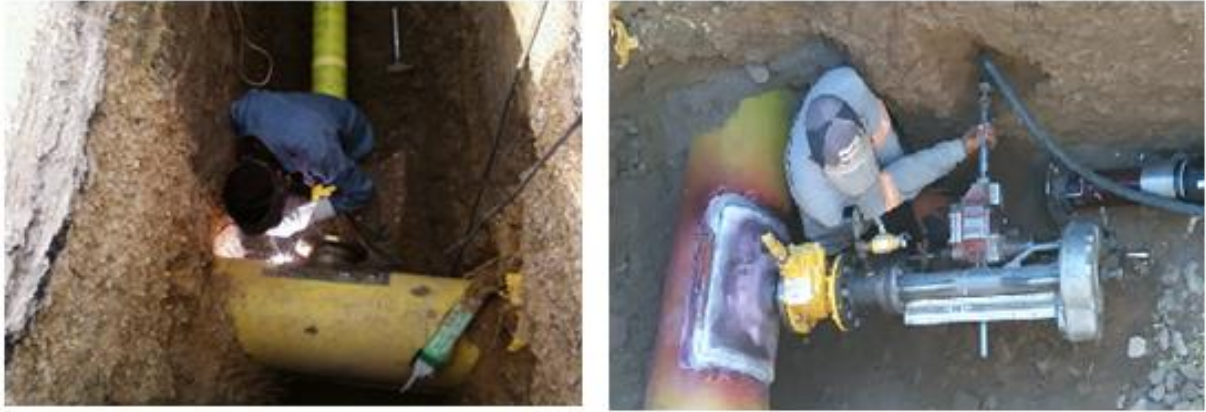
Resim 4.2. Hot-tap operasyonu kaynak ve delme işlemleri
