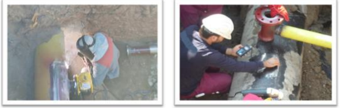
Resim 2.1. Semer kaynağı – ultrasonik boru et kalınlığı testi
