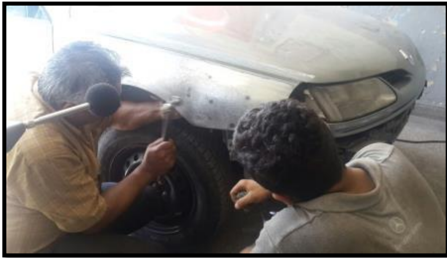
Resim 2.1. Çekiç ve dayama ile düzeltme
