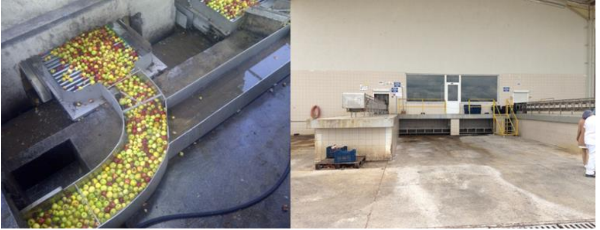
Resim 4.4. Uygun Korkuluk Bulunmaması
