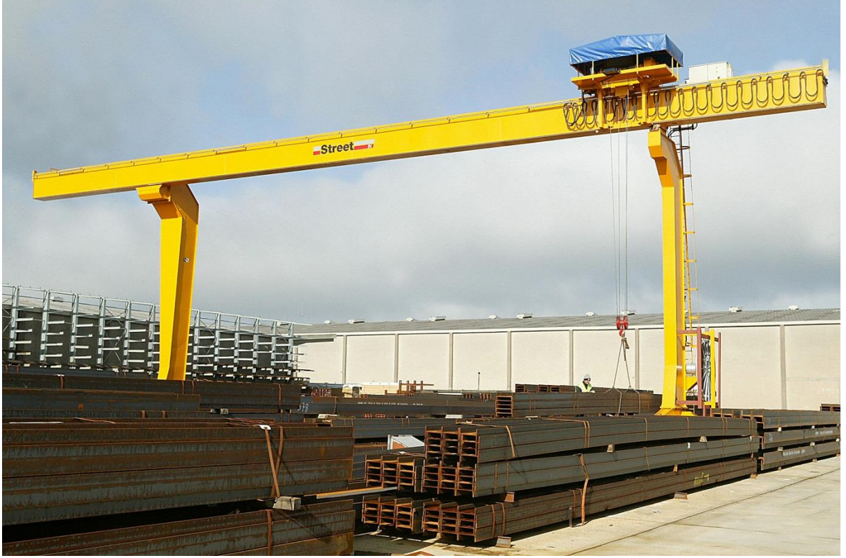
Şekil 2.5. Çelik konstrüksiyon depolama sahası
