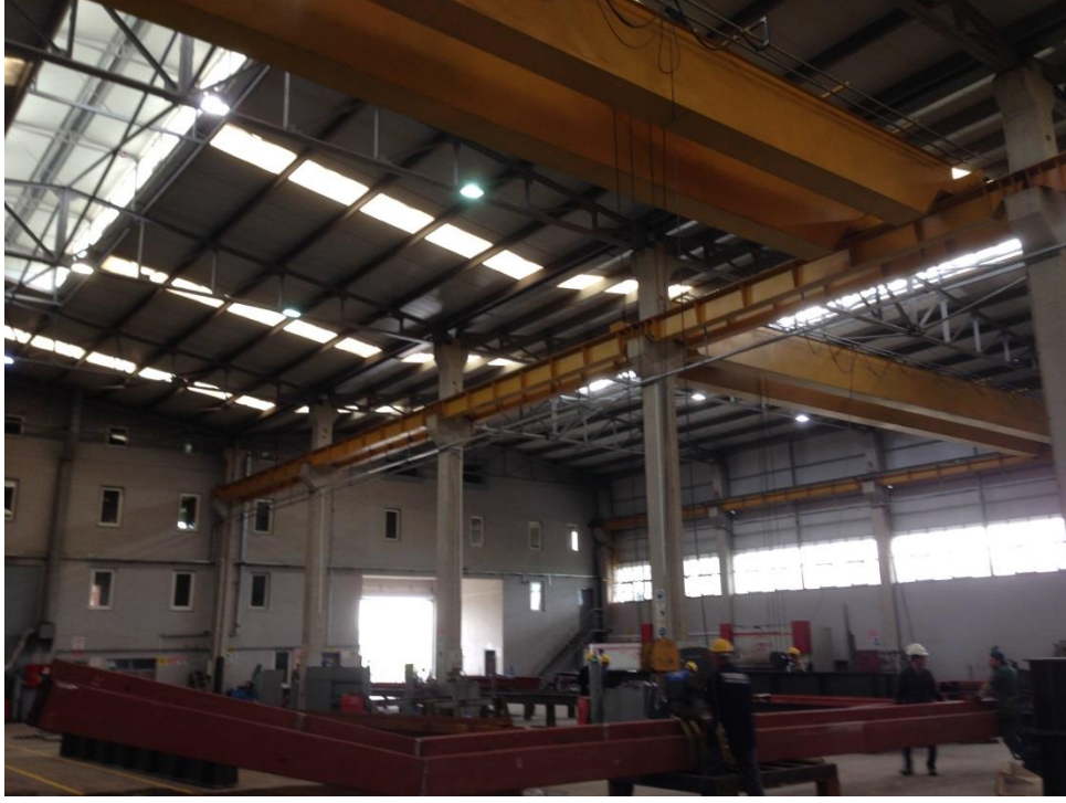
Şekil 2.15. Gezer vinç ile malzemelerin taşınması
