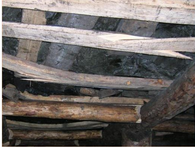
Resim 2.2. Eksik Kama Sonucunda Deformasyona Uğramış Tavan Tahkimatı [22]
