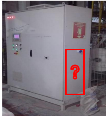
Resim 4.9. Kullanıma hazır olmayan yangın tüpleri
