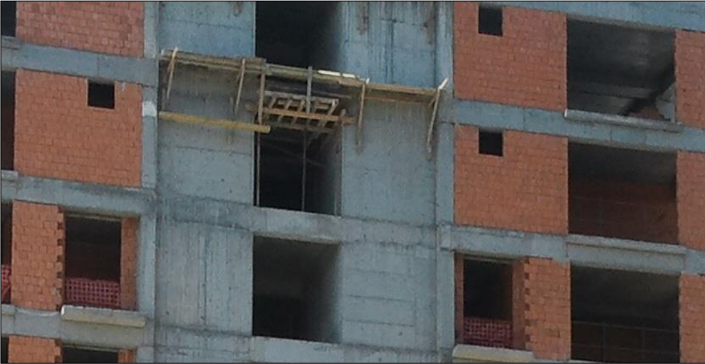
Resim 4.11. Yüksekte çalışmada alınmayan önlemler-1
