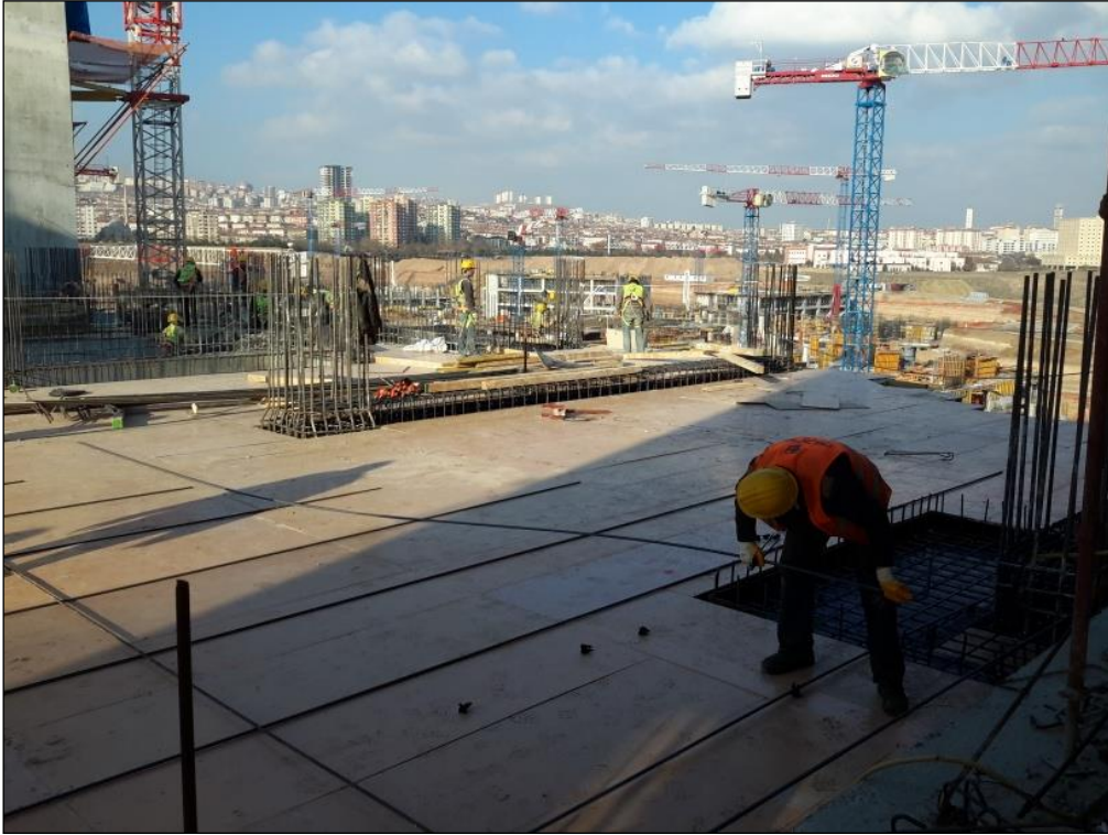
Resim 4.9. Kat döşeme beton atılması öncesi hazırlık işleri
