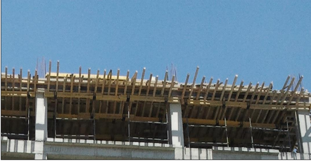
Resim 4.12. Yksekte alıřmada alınmayan nlemler-2
