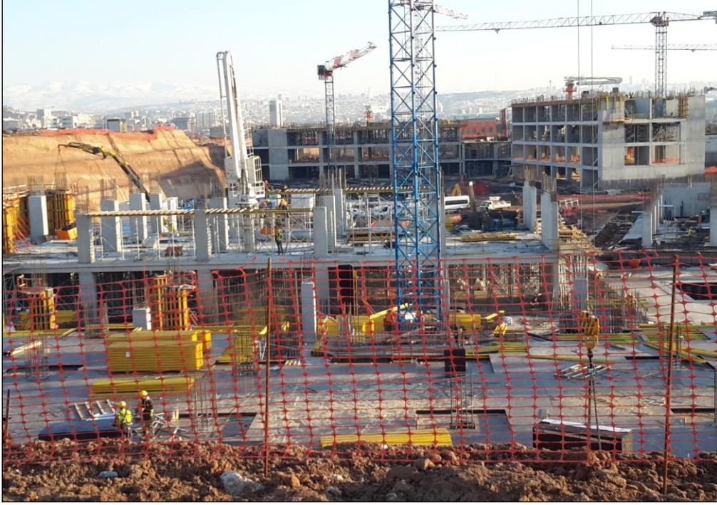
Resim 4.7. Emniyet alan perdesi ile üst kottan erişimin kısıtlanması-2
